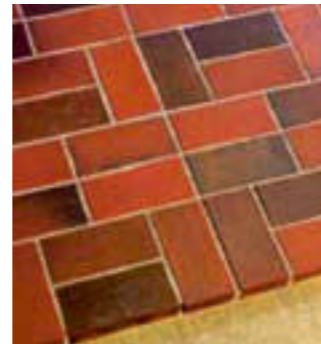
Модульная укладка с вариациями
