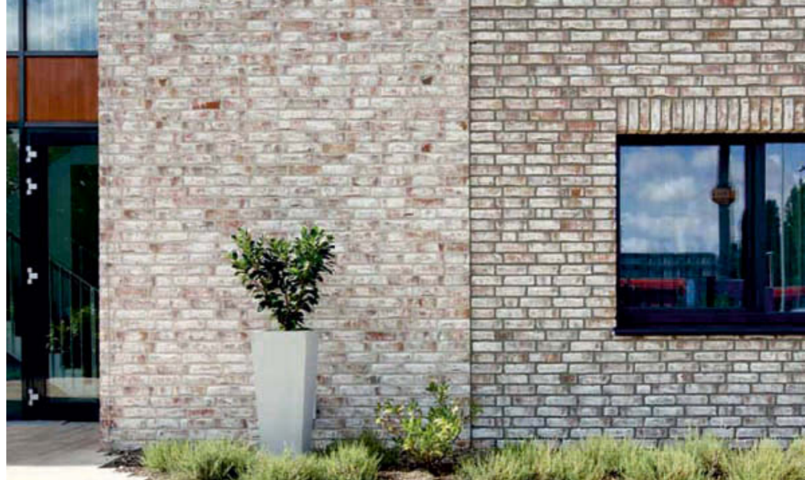
Облицовочный кирпич ручной формовки фирмы Röben GEESTBRAND белый пестрый был использован здесь с двумя различными цветами швов.
