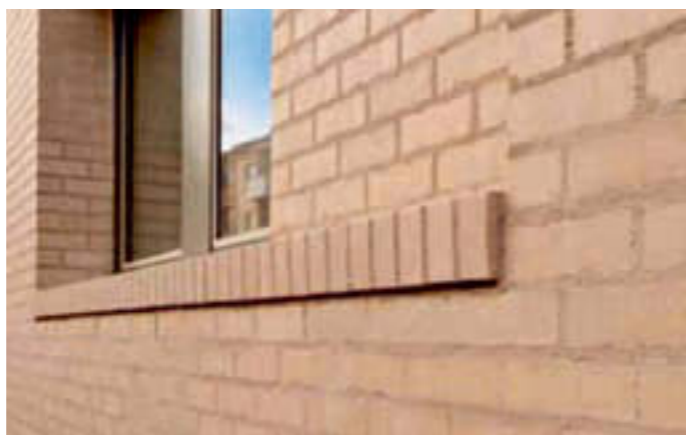
Заполненные раствором швы, выполненные заподлицо без дополнительного уплотнения.
