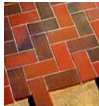
Укладка в елочку
