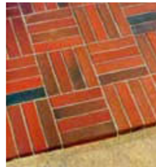
Модульная укладка дорожной брусчатки
