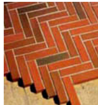
Укладка дорожной брусчатки в елочку
