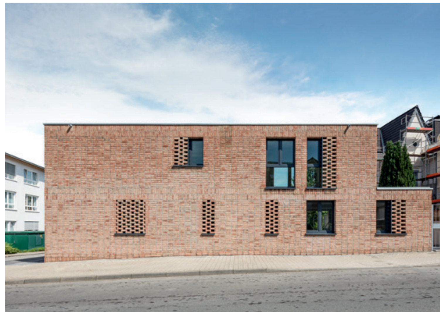
Nach Süden hin erscheint das gering geneigte Satteldach optisch als Flachdach. Die unterschiedlichen Details belegen auch hier die große Flexibilität der Röben-Handformriemchen. Die Lochmauer-Elemente wurden mit Vollklinkern erstellt.
