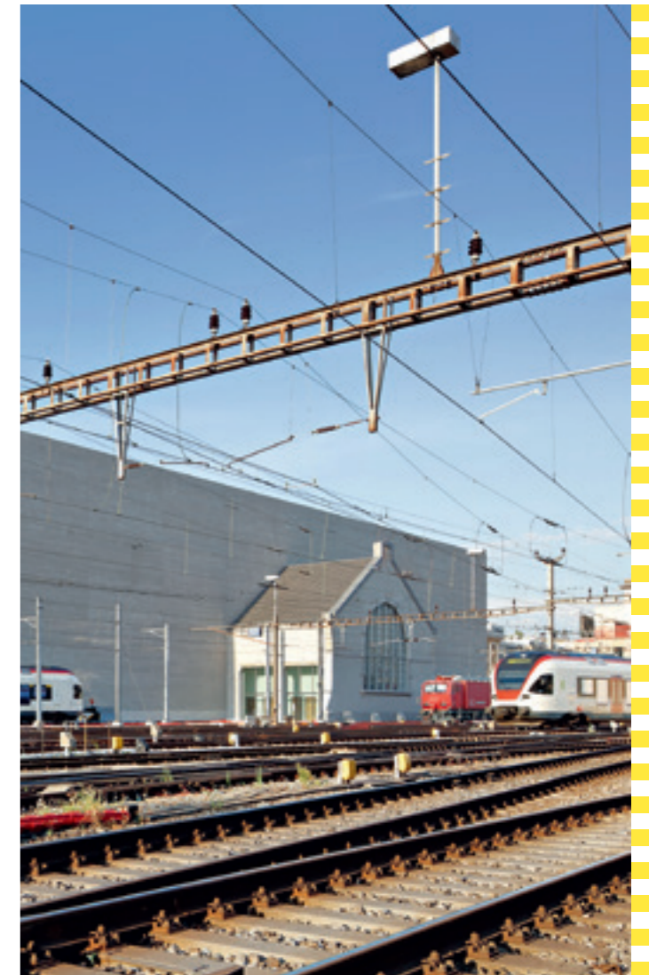
■ Ansicht von den Gleisen aus: Der Einsatz der vorgefertigten Elemente ermöglichte einen schnellen und kostengünstigen Bau-fortschritt.
